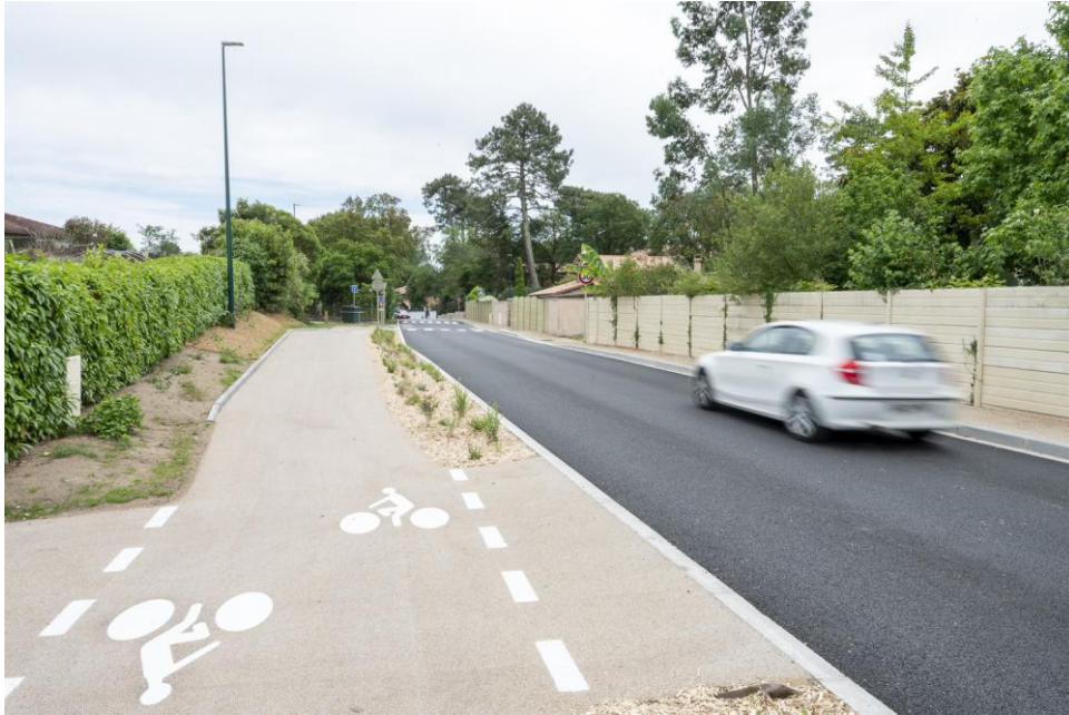
Nouvel aménagement cyclable à Labenne
