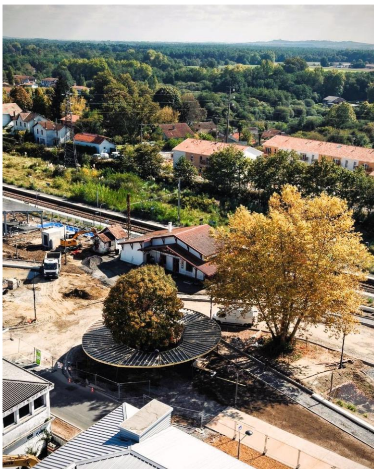
Travaux du Pôle d'Échange Multimodal
