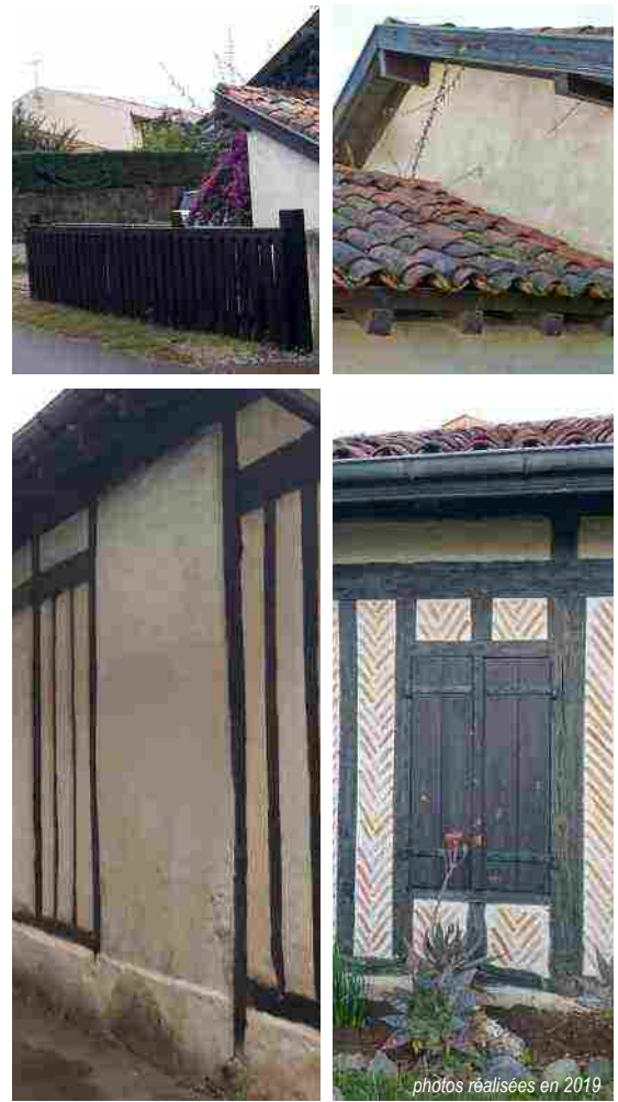
photos réalisées en 2019
