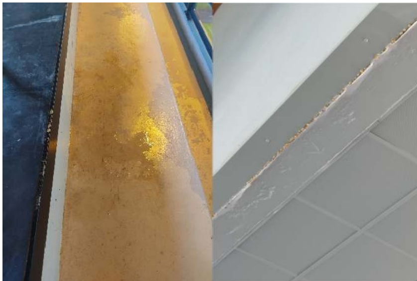
-Fuites à cause des descentes eaux pluviales
