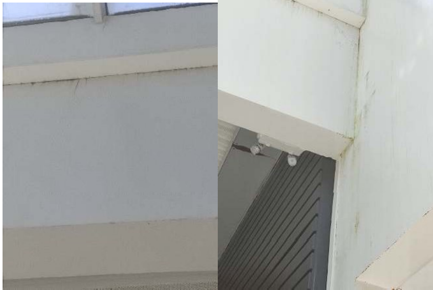
-Fuites à cause des descentes eaux pluviales
