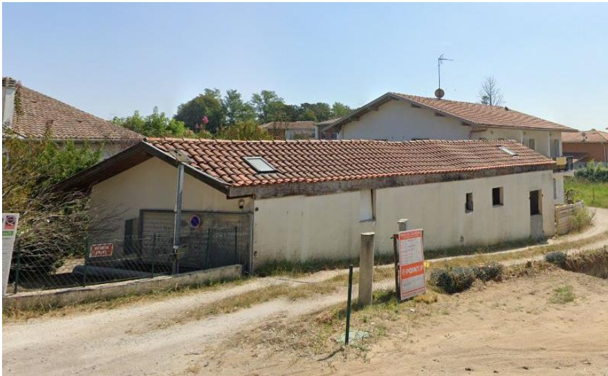
19. 5BIS AV DES TUCS DOUS BROCS
