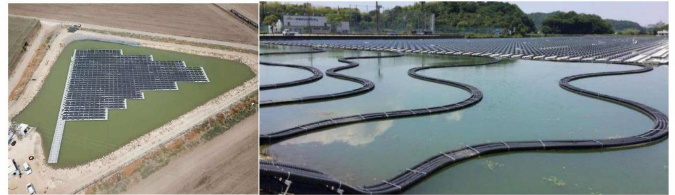
Figure 6 : Exemple de pontons et de câbles utilisés sur les centrales photovoltaïques flottantes (Source : C&T )
