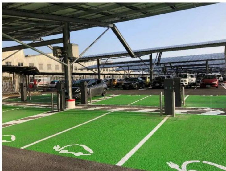
Figure 25 : Places de parkings à Vichy avec bornes de recharge électrique - Source : TotalEnergies Renouvelables France
