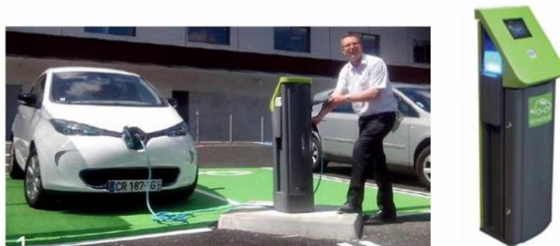
Figure 24 : Bornes de recharge électrique
