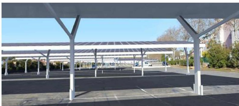
Figure 13 : Ecart entre les pylônes
