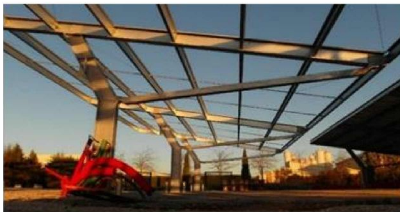
Figure 12 : Exemple d'ombrières fournies par Heliowatt - Source : TotalEnergies Renouvelables France
