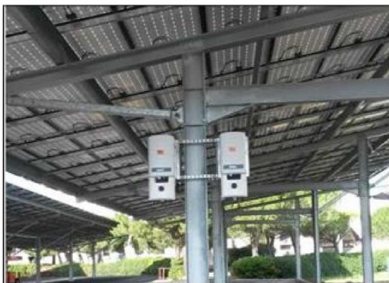
Figure 15 : Exemple d'onduleur sur pylône
