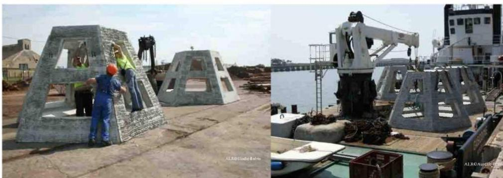
Figure 12 Montage et chargement des récifs Typi. Source: ALR
