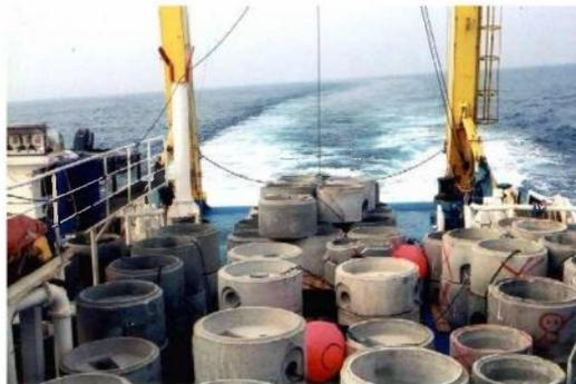
Figure 7 Buses prêtes à être immergées sur la concession de Soustons/Vieux-Boucau. Source: ALR
