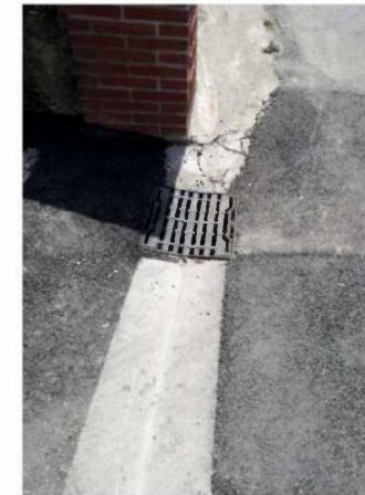
Figure 18 - Dispositifs de collecte des eaux de ruissellement
