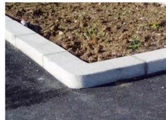
Figure 5 - Bordures en profil "pierre"
