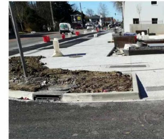
Figure 18 - Dispositifs de collecte des eaux de ruissellement
