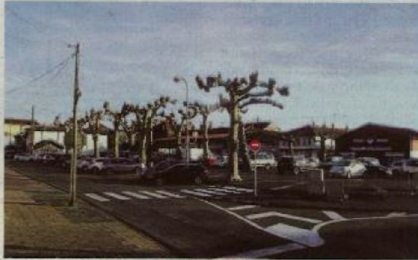
La place du Foirail se redessine, sans les platanes, sans dénivelés, avec un nouveau marché couvert et ouvert. PHOTO G.H.L.
