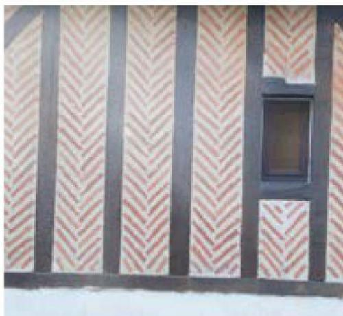
Bâti à pans de bois et à maçonnerie enduite (gauche) et à maçonnerie décorative (opus spicatum).
