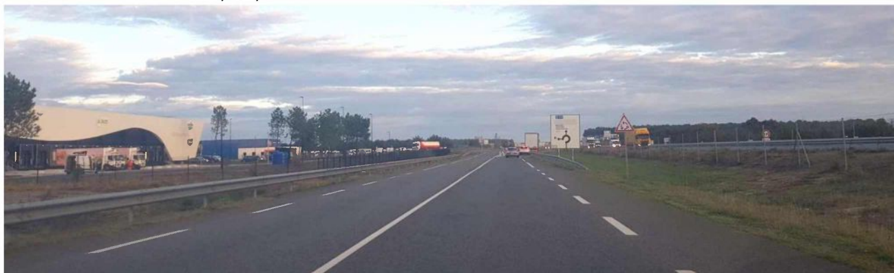
Photo 1- partie sud au droit de l'entreprise de transport de frais 'Le Saint' : La bande de recul est occupée par les bassins de rétention et les voies.
