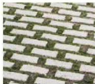
Pavage en béton avec ouvertures de drainage
