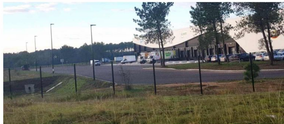
Photo 3- bassins de rétention devant 'Le Saint'
