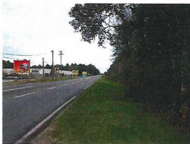
Vue Sud-Est : Garages et au fond le bâtiment de meubles en ruine
