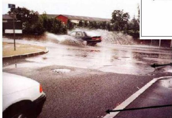
Chaussée à structure réservoir, Craaponne (CERTU - 1994)
