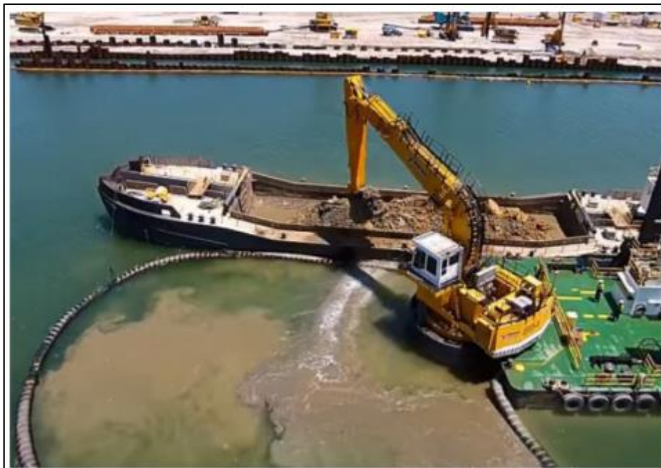
Figure 4 - Exemples de mise en œuvre de barrages anti MES sur un site de dragage mécanique (Géode, 2018)
