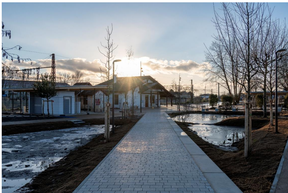
Aménagement du PEM à Saint-Vincent-de-Tyrosse, noues et revêtement bas carbone
