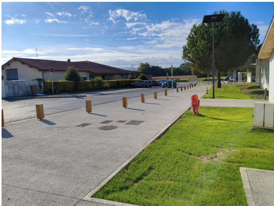
Désimperméabilisation de l'école de Saint-Martin-de-Hinx et création d'une noue.
