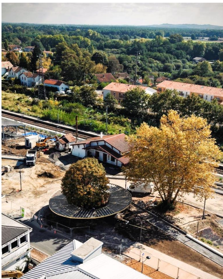
Travaux du Pôle d'Échange Multimodal
