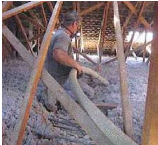
Principe de l'isolation des combles praticables. Pose d'isolant entre chevrons sous la couverture. Source : L'isolation thermique écologique, Oliva et Cougey, 2010.
