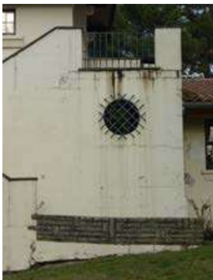
Altérations des bétons liées aux intrants marins: la présence de sel dégrade les bétons et les aciers, les peintures.
