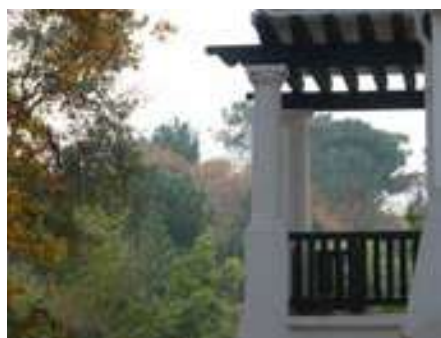
La loggia surmontée d'une pergola ou d'une ombrière est un des grands motifs de l'architecture Régionaliste : en structure béton et bois.
