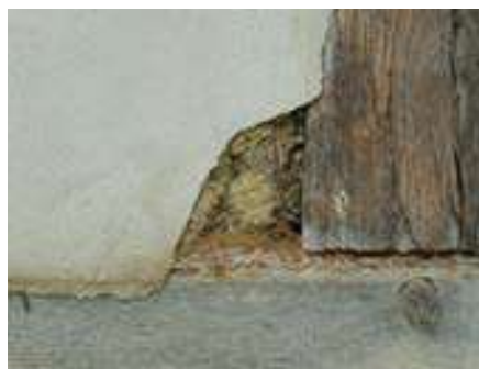
Détail : soubassement maçonné, structure en pan de bois, remplissage des panneaux en torchis et enduit de protection.
