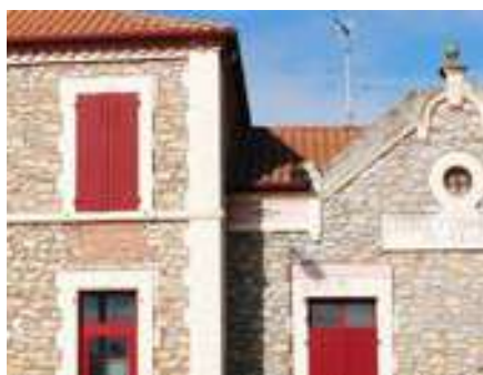
Maçonnerie de moellons hourdée. Un enduit et un badigeon sont nécessaires pour la protéger.
