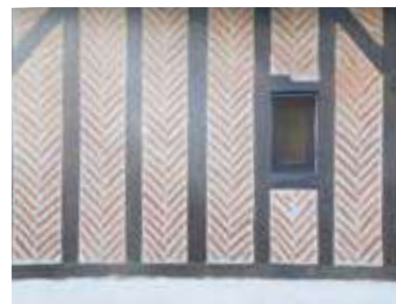
Pan de bois, remplissage briques appareillées en fougère
