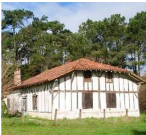
Bâti à pans de bois et à maçonnerie enduite (gauche) et à maçonnerie décorative (opus spicatum).
