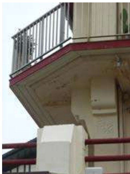
Altérations des bétons liées aux intrants marins: la présence de sel dégrade les bétons et les aciers, les peintures.
