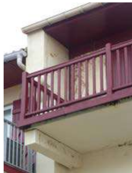
Altérations des bétons liées aux intrants marins: la présence de sel dégrade les bétons et les aciers, les peintures.
