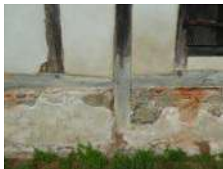
Détail : soubassement maçonné, structure en pan de bois, remplissage des panneaux en torchis et enduit de protection.
