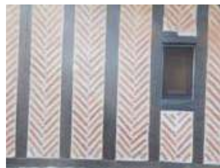
Pan de bois et remplissage en brique, motif en fougère.
