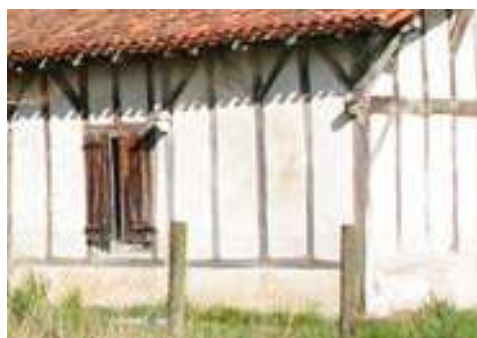
Pans de bois à grille sur la ferme et l'architecture traditionnelle landaise.
