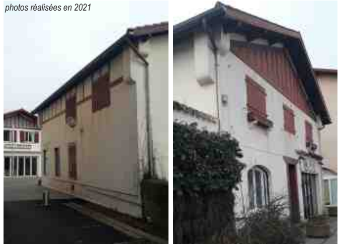
photos réalisées en 2021
