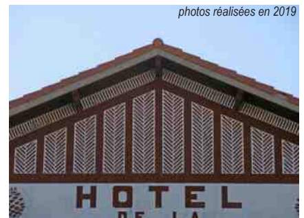
photos réalisées en 2019
