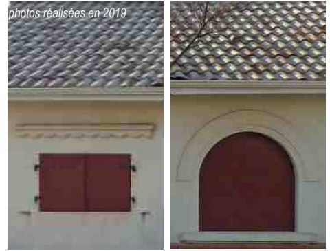
photos réalisées en 2019
