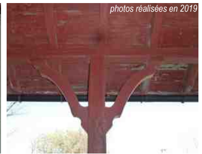
photos réalisées en 2019
