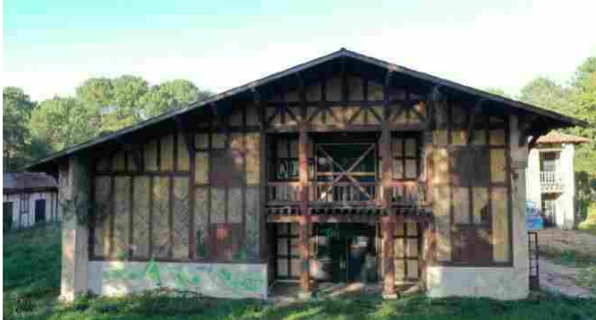
Façade sud bâtiment principal
