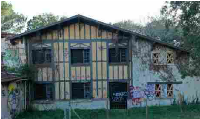
Façade nord bâtiment principal
