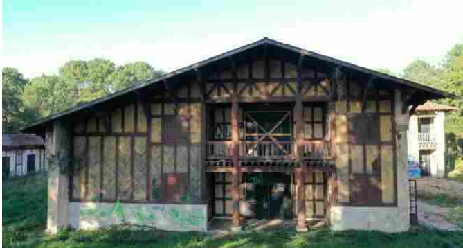
Façade sud bâtiment principal
