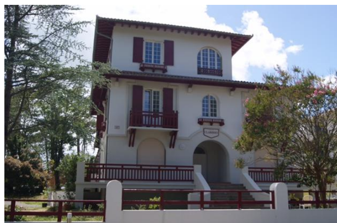
Maison Relai à Labenne // Source : SOLIHA Landes
