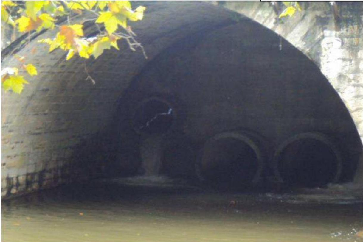
L'arche du pont situé sous l'avenue de la Résistance est obturée par un mur, ce mur est traversé par des buses servant à l'écoulement des eaux du lac à partir de l'ouvrage de régulation et des déversoirs.
