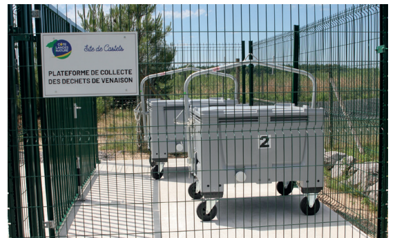
exemple de plateforme installée à Castets
