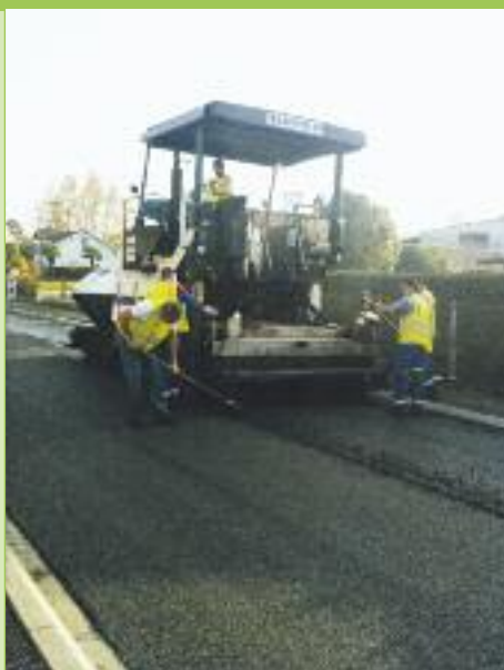
Rénovation des enrobés à Tosse
