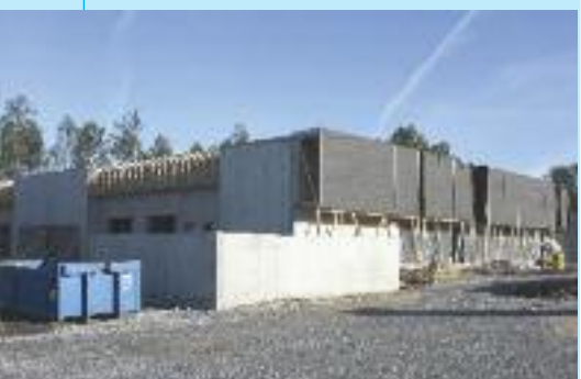
Etat des travaux du 31/12/2010
