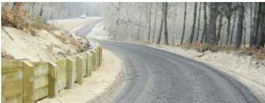
Les premiers travaux le long de la future voie verte littorale
