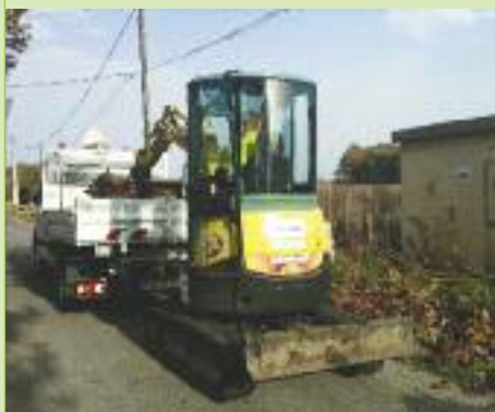
Curage des fossés
